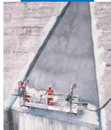
Ukázka Mapelasticu aplikovaného nástřikem na přehradní hráz
