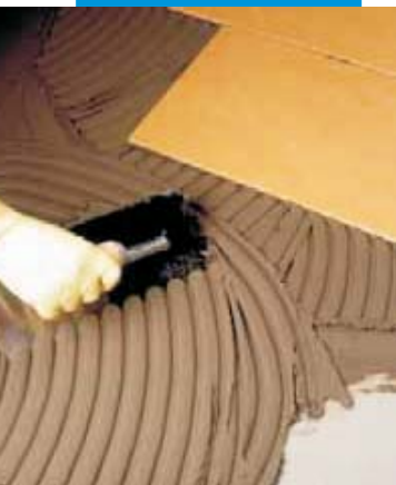
kladení keramické dlažby do Elastorapidu na podklad z lodní překližky
