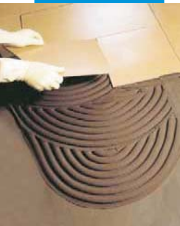
kladení keramické dlažby na potěr izolovaný Mapecelastice
