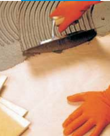
nanášení Elastorapidu zubovou stěrku na cementový potěr
