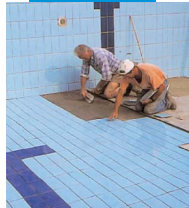
Lepení keramického obkladového materiálu na Mapelastic v bazénu
