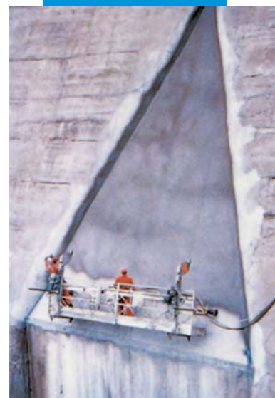
Ukázka Mapelasticu naneseného nástřikem na stěnu přehrady
