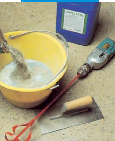
Míchání Mapelasticu mechanickým míchadlem
