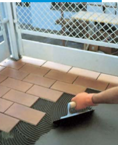
Lepení obkladového materiálu Granirapidem na balkon ošetřený Mapelasticem
