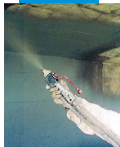
Ukázka nanášení Mapelasticu na viadukt nástřikem
