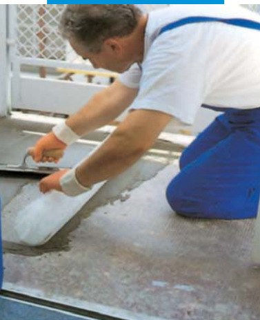
Hydroizolace balkonu Mapelasticem vyztuženým síťovinou ze skelných vláken
