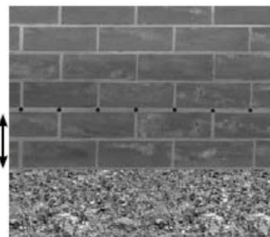
ukázka vyvrtání otvorů
