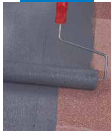
Nanášení Eco Primu Grip válečkem na stávající dlažbu z terazza
